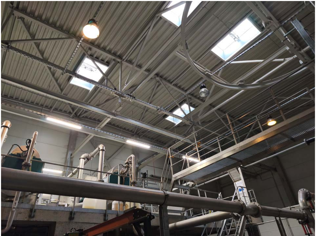
09 pav. Stogo konstrukcijų fotofiksacija
