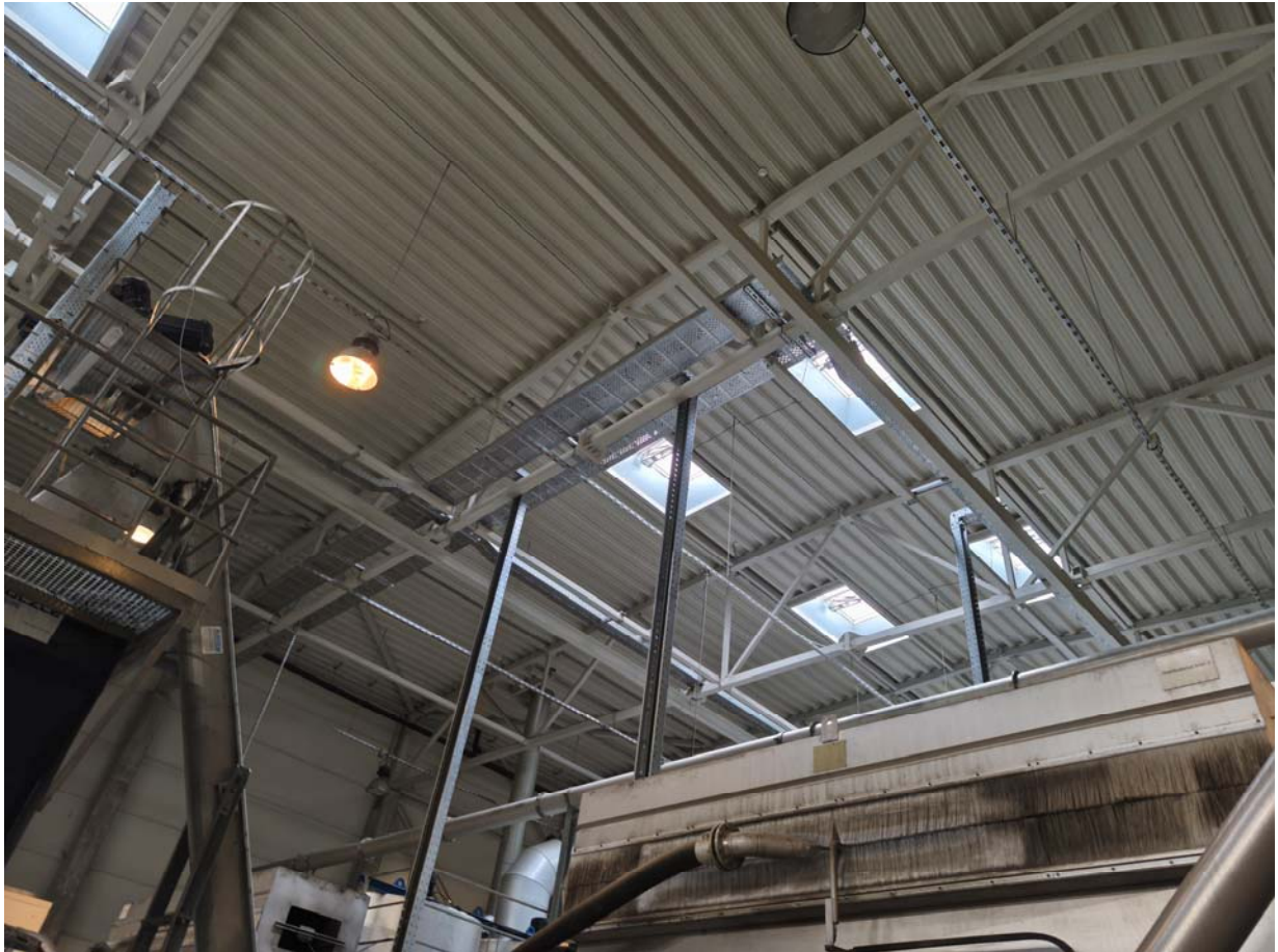
07 pav. Stogo konstrukcijų fotofiksacija
